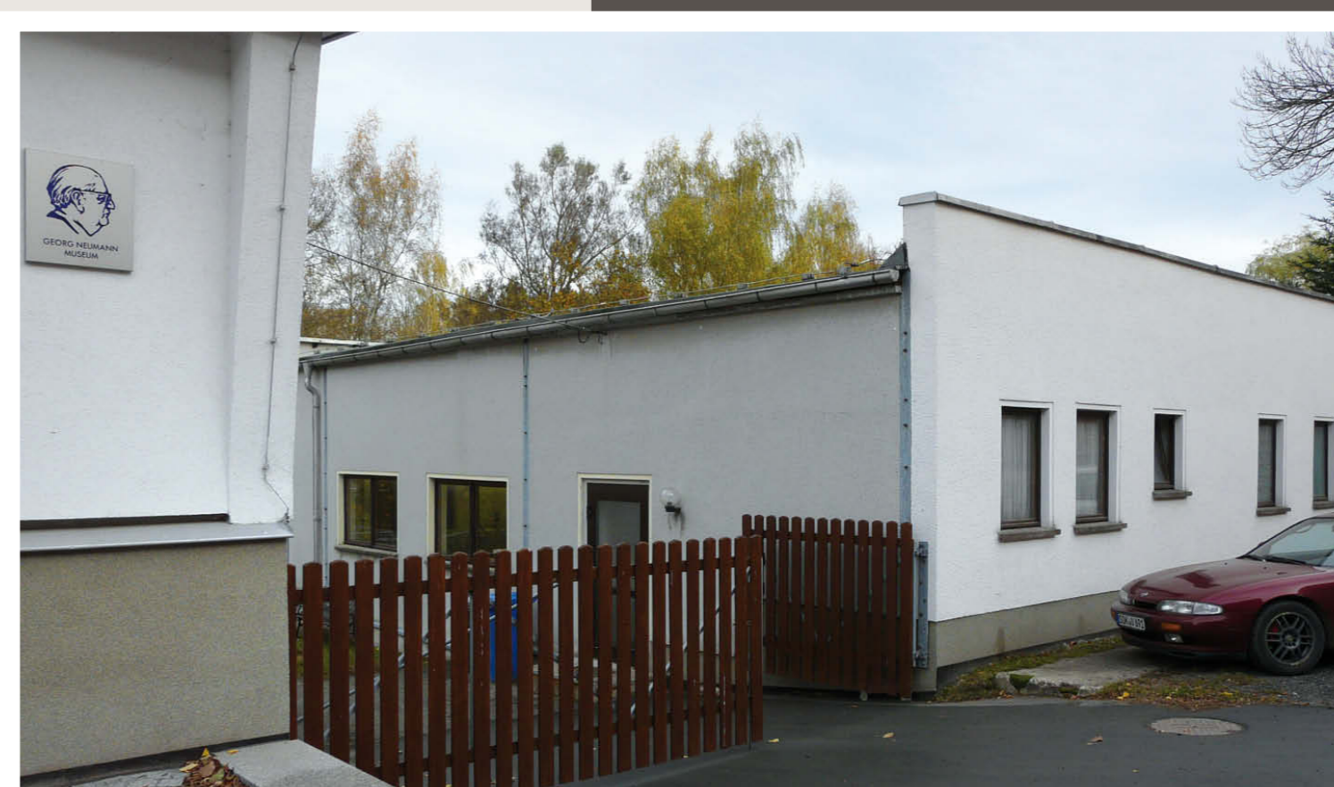
Vorfertigung der Microtech Gefell GmbH Pre-fabrication of Microtech Gefell GmbH
